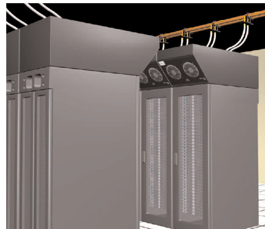
Rys. 14. Chłodzenie wspomagające wysokiej gęstości umożliwia większe upakowanie rack'ów i wyższą wydajność chłodzenia.
